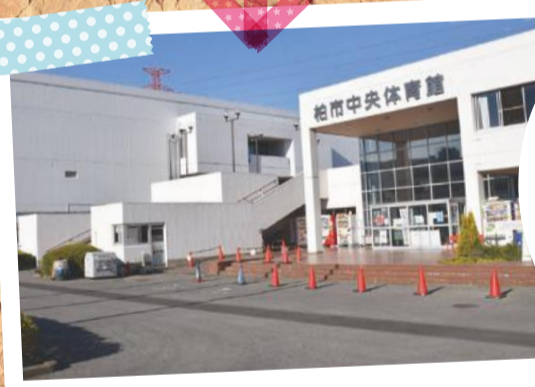
中央体育館外観 令和3年3月15日から、一般開放を再開する予定です。
