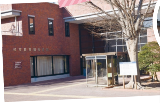
教育福祉会館外観 令和3年1月18日から一部の利用を再開しました。
