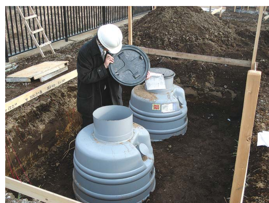
【マンホールトイレ設置状況及び使用方法（イメージ）】
