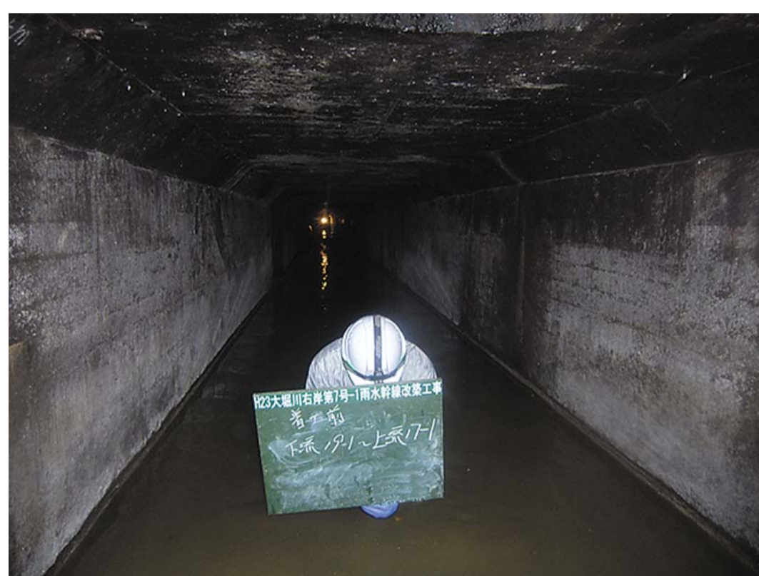
耐震化工事 工事前
