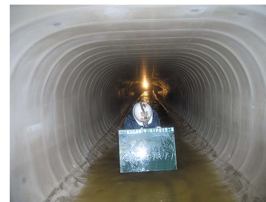
耐震化工事 工事後
