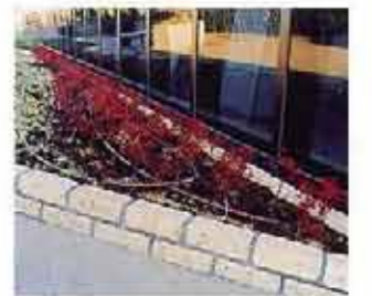
■雨水利用の散水用設備
