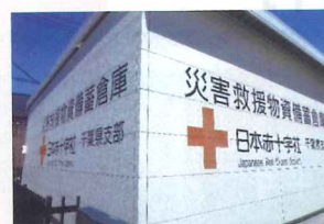
災害救援物資拠点倉庫(市川市)
