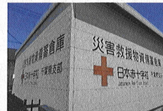
災害救援物資拠点倉庫(市川市)
