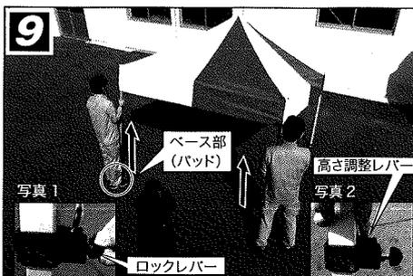
9 ベース部 (パッド) を足で踏みながら、両端の OUTER-LEG のロックアジャスターJ に付属している「ロックレバー」が解除になっている事を確認した上で (写真1)、「高さ調整レバー」を押し込みながら (写真2)、アウターレグを伸ばします。
