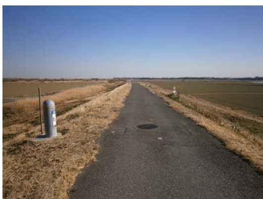
サイクリング道路の現況（柏市布施）
