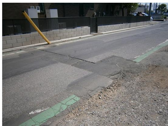
いても設置されて間もないと思われる新しい区画線の存在を確認できたが、5地点のうち高田における施工箇所についてだけは、案内図上で対象区間として示されている区間に直近に区画線が設置されたような形跡は全く見受けられず、至る所に陥没やひび割れが見られ、かなり前に設置されたと思われる区画線も複数個所で磨耗が進んでいるという現況であった。（右側写真参照）
