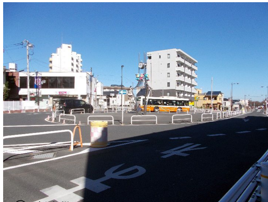
② 暫定供用中の鶴瀬駅東口駅前広場
