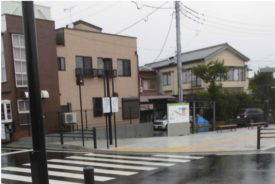
駅前広場左側 道路状況
