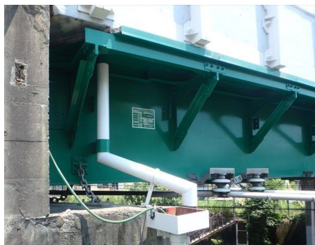
図-5 塗替工事(第三浜街道跨線道路橋)
