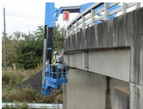
図-4 橋梁点検車による点検(弁天下橋)
