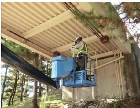
図-4 高所作業車による点検
