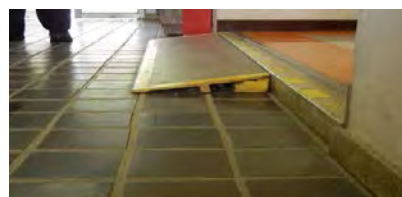
バリアフリーではない建物の内部
