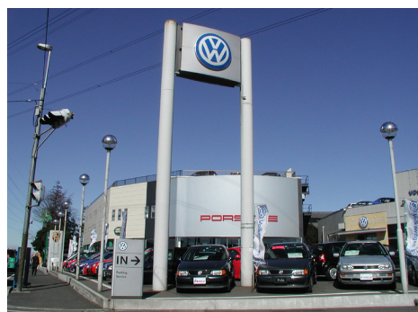
シンプルで洗練された建物、サイン、照明のデザインとなっています。(十余二)
