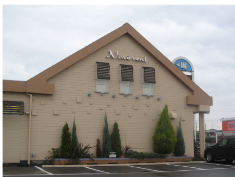
外壁のデザインと一体となっている排気口。植栽もあり目立ちにくくなっています。(小山市)
