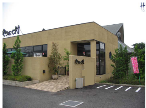
外壁の素材感やシンプルな建物デザイン、周囲の緑が一体となって、落ち着きを感じられます。(大和市)
