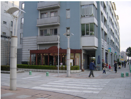
1階部分をセットバックし歩道状空地を確保している。(幕張)
