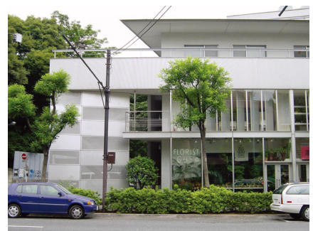
建築デザインに合わせた外階段の目隠し（左側）（渋谷区）
