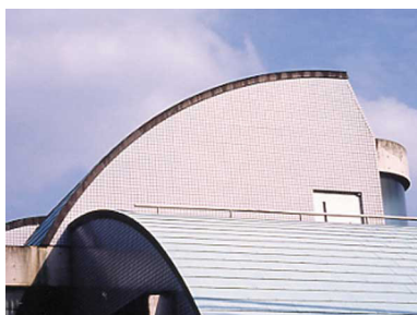
屋上の設備類を屋根で囲って修景しています。(世田谷区)
