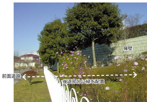
前面道路からの後退部分に緑を配置し、擁壁の圧迫感を軽減している。(石岡市)
