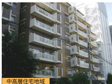
中高層住宅地域 建物デザインの一部として設備室をバルコニーに設けています。(文京区)
