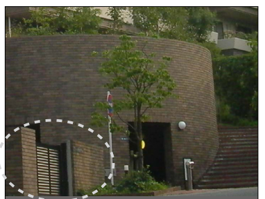
建築と一体的な外壁により囲まれたゴミ置き場 (秦野市)
