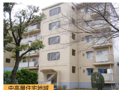
中高層住宅地域 外階段を建物デザインに組み込んでいます。(文京区)
