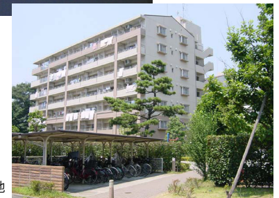
柏の葉住宅地
