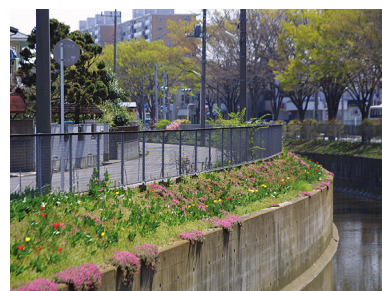
地金堀（緑化ボランティアによる水路脇の花植えと手入れ）
