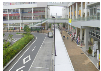
豊かな歩道やデッキなどで結ばれた回遊性の高い駅前空間（南柏）
