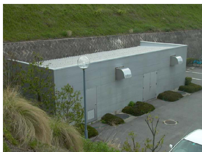
設備室の壁面を修景し、まわりに植栽を配置しています。(池田町)
