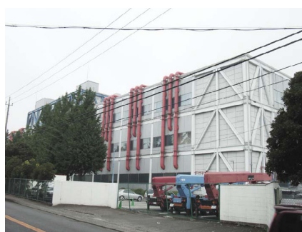
配管類にアクセントカラーを用い、壁面デザインをひきしめています。(秦野市)
