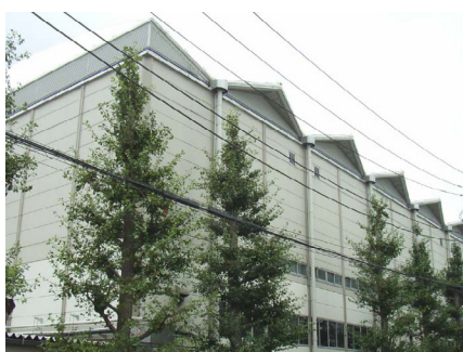
外壁と同系色を用いた配管類が、壁面に表情を与えています。(秦野市)
