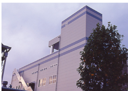
アクセントカラーを用いることで壁面が単調になるのを避けています。(戸田市)
