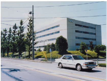
敷地外周にマウンドアップされた豊かな緑の空間を配置しています。(相模原市)
