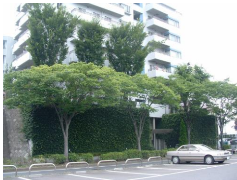
擁壁を緑化した集合住宅（松ヶ崎）
