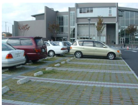
雨水の地下浸透に配慮した駐車場 (リフレッシュプラザ柏)
