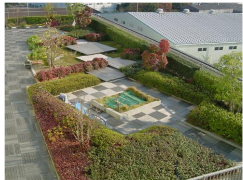
柏市リサイクルプラザの屋上緑化
