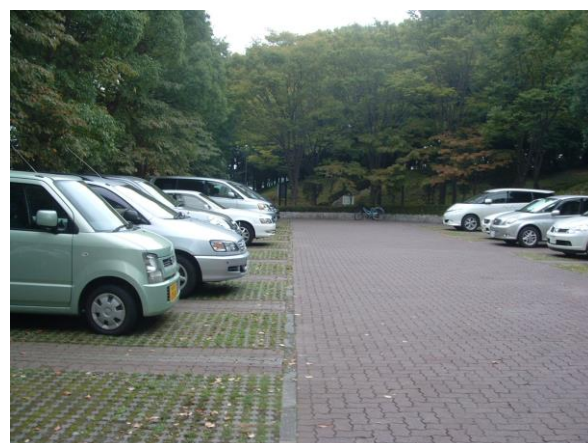
雨水の地下浸透に配慮した駐車場 (南部公園)
