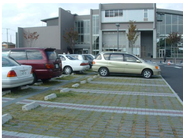
雨水の地下浸透に配慮した駐車場 (リフレッシュプラザ柏)
