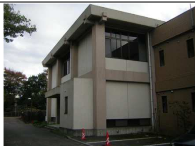
北部近隣センター体育室（館）
