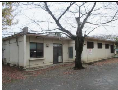
柏市西口第一公園市民プール
