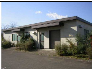
県立柏の葉公園柏市倉庫
