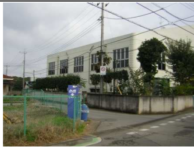
酒井根近隣センター体育室（館）
