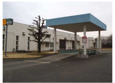
山高野浄化センター
