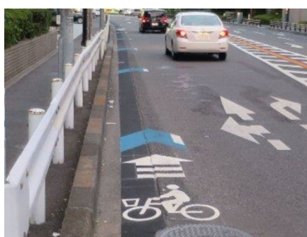
・路面表示の例 出典:吹田市
