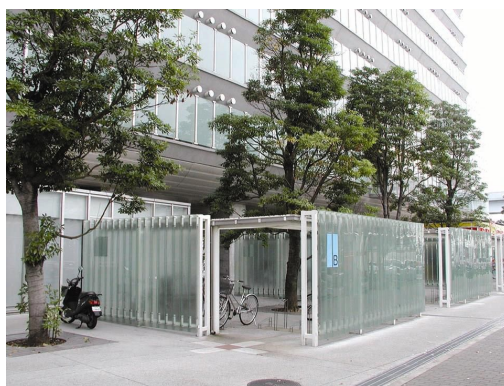
自転車置き場を半透明のパネルで覆い，緑との組み合わせでさらに目立ちにくくすっきりとデザインしている例
