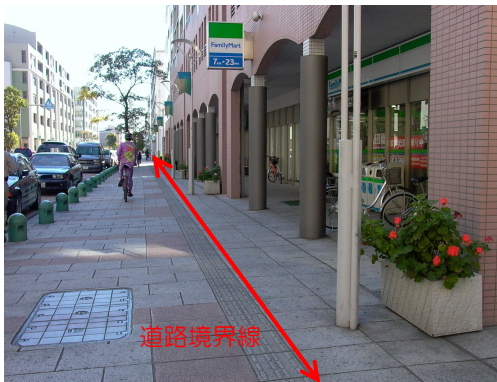
壁面後退部分のレベル、舗装材、目地位置を歩道部分と協調し、境界部を舗装材の色彩でゆるやかに表現して一体的な空間とした例
