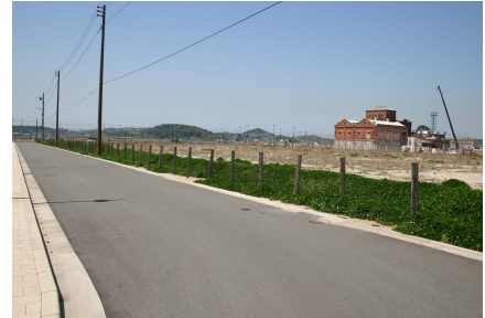
敷地のきわを播種で緑化し、修景するとともに土砂の飛散を防止している例
