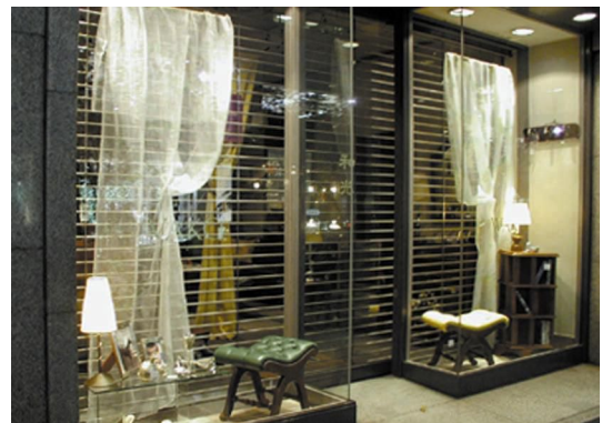
シャッターをショーウィンドウの内側に設けるデザイン
