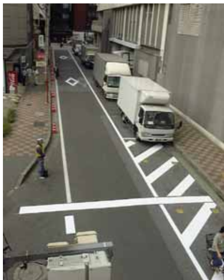
柏市における路上荷捌き駐車帯
