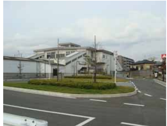
駅改良が済んだ逆井駅
