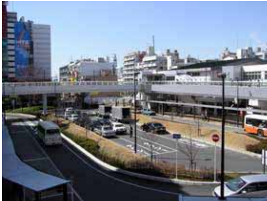
完成した南柏駅東口駅前広場
