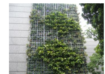
壁面緑化（東京都千代田区）
