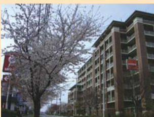
A-1 増尾台の優良老人ホーム 柱や屋根などが重厚感を感じさせる近代建築風の建物です。
