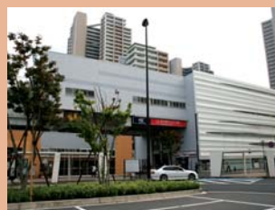
6-7 柏の葉キャンパス駅駅舎 壁面のデザインが印象的な駅舎。
