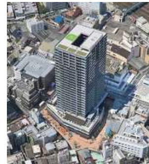
(柏駅東口D街区第一地区市街地再開発事業)
