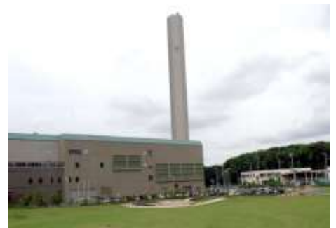
ごみ焼却場 (柏市第二清掃工場)
