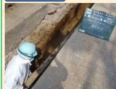
老朽管撤去状況
