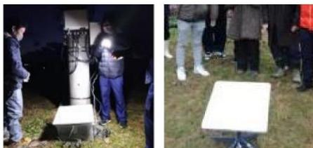
▲断絶した通信ケーブルの代替回線に利用し携帯電話の基地局を応急復旧
