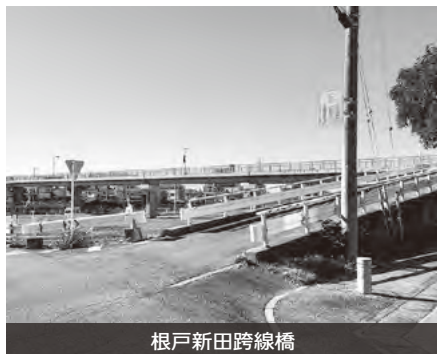
根戸新田跨線橋
