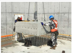
下部基礎PCa設置状況例
