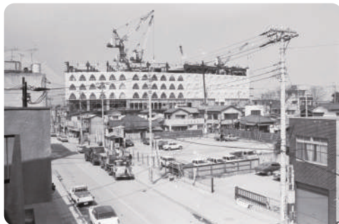
そごう柏店建設現場
