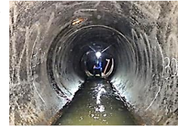
改築工事（管更生）施工前
