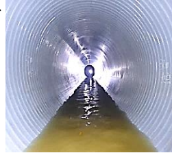
改築工事（管更生）施工後
