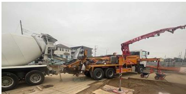
コンクリート打設状況
