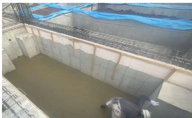
型枠撤去状況
