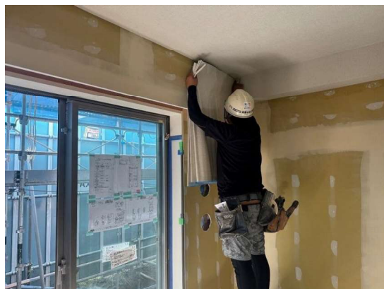
内装工事（クロス、塗装、ボード）
