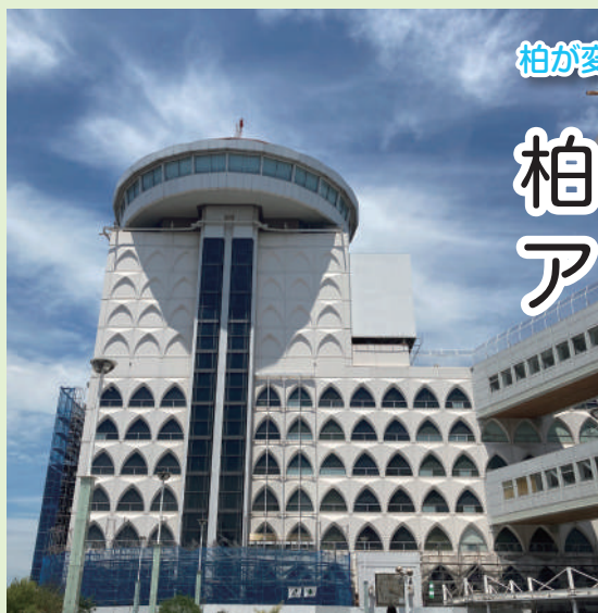
解体中の旧そごう柏店の様子
