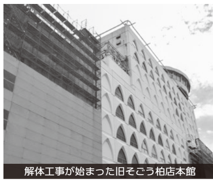
解体工事が始まった旧そごう柏店本館
