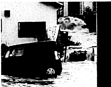
道路の陥没に前輪が落ちた車と、マンホールから噴き出す汚水交じりの下水（右奥に灰色のかたまりのように見える）
