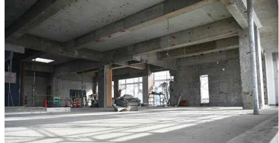
▲工事中の写真
