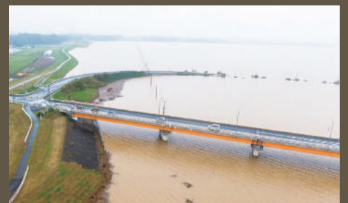
▲上空から見た、台風で増水した利根川(田中調節池)
