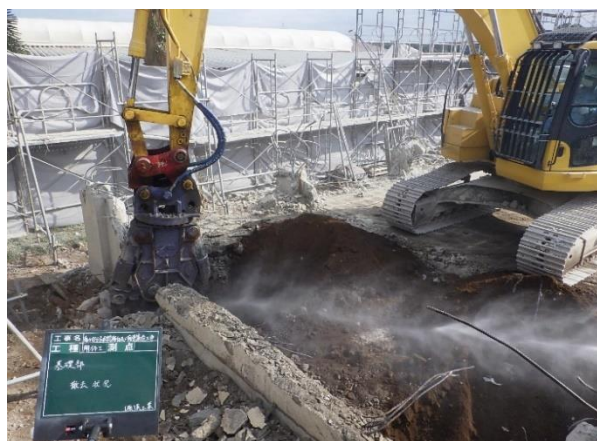
大割油圧圧砕機による基礎撤去
