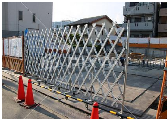
仮囲い・仮設ゲート
