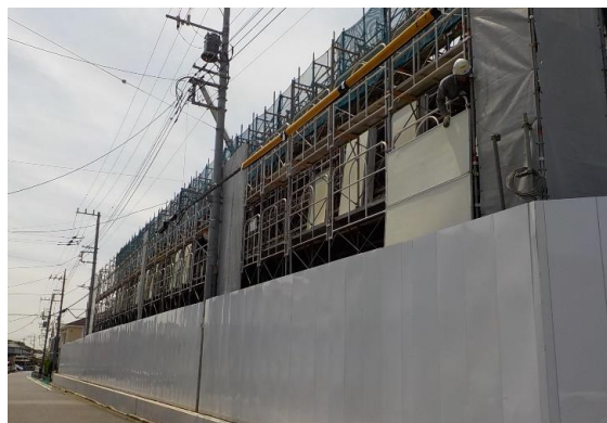
外部足場・防音パネル
