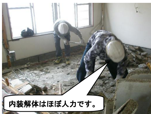
内装人力解体
