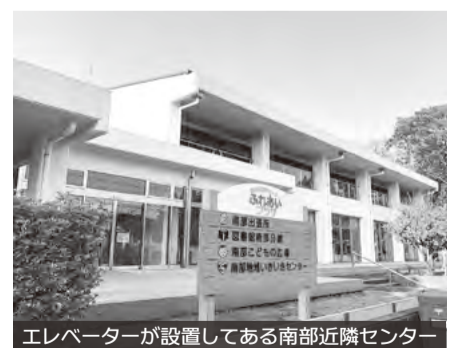
エレベーターが設置してある南部近隣センター
