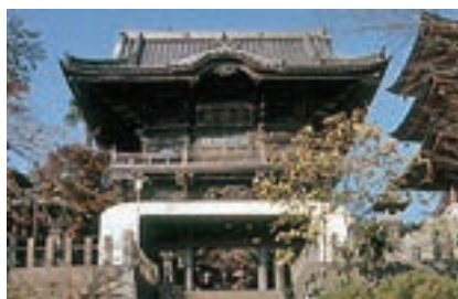
写真 7-22：布施弁天東海寺 楼門
