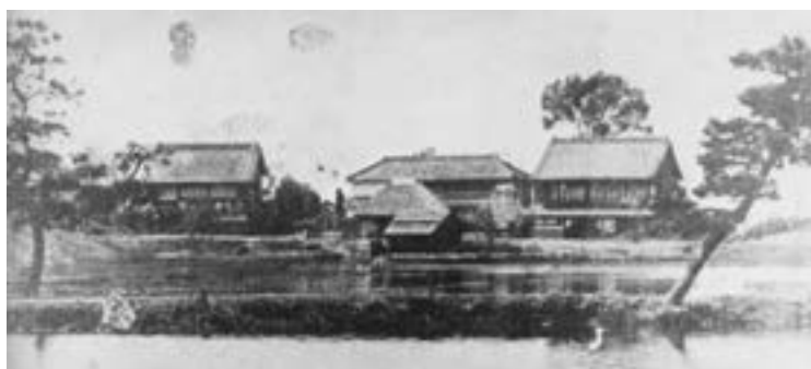
写真 7-20：橋本旅館前身建物（大正期か）
