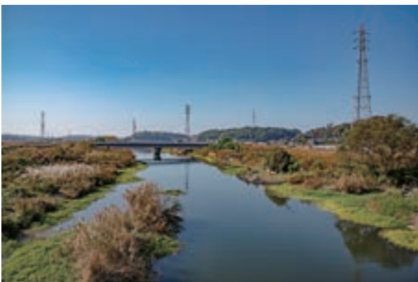
写真 1-3：大津川河口上流
