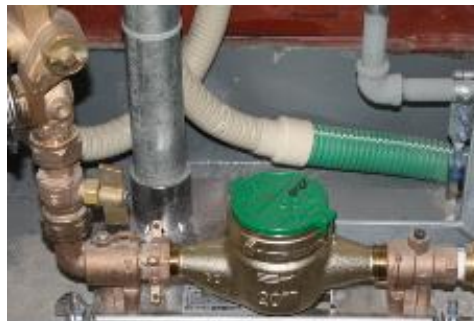
Interior de la caja de tuberías
