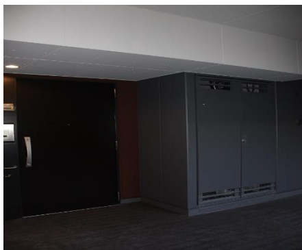
Caja de tuberías
