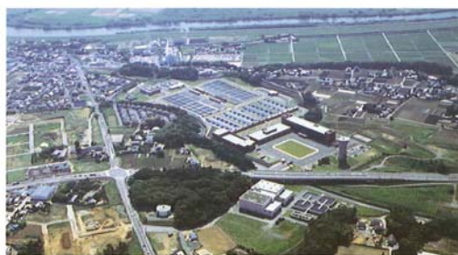
浄水場（流山市）
