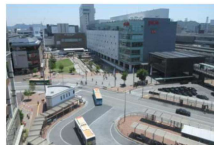
姫路駅 (民間敷地を活用し広場空間を拡充) 出典：国土交通省HP
