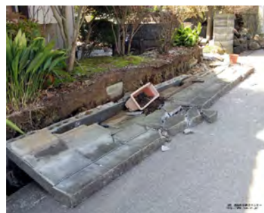
危険コンクリートブロック塀等の除却
