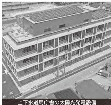
上下水道局庁舎の太陽光発電設備
